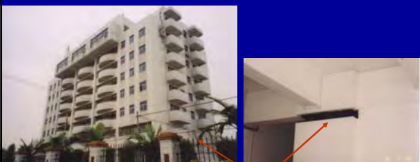
Isolators 首层隔震
